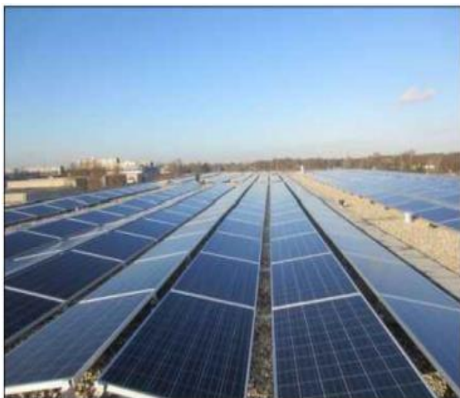
Figuur 9 Voorbeeld aanzicht panelen met oost-west oriëntatie
